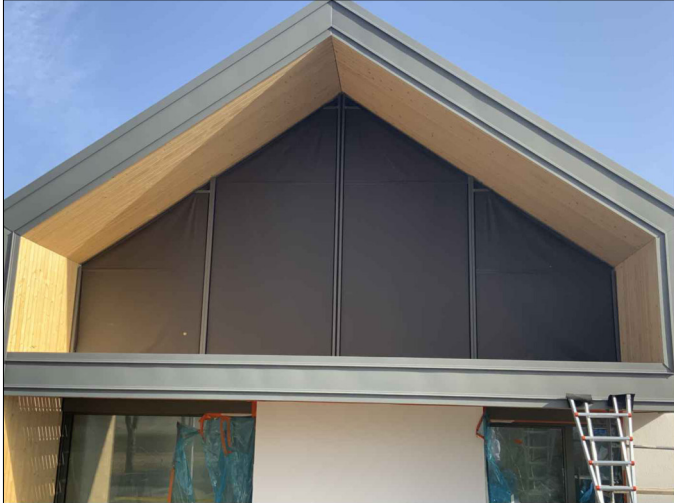
Stores de formes trapézoïdales pour les bureaux de l'agence architecture Hoffman à Wëntger au Luxembourg (Entreprise : Laloux)
